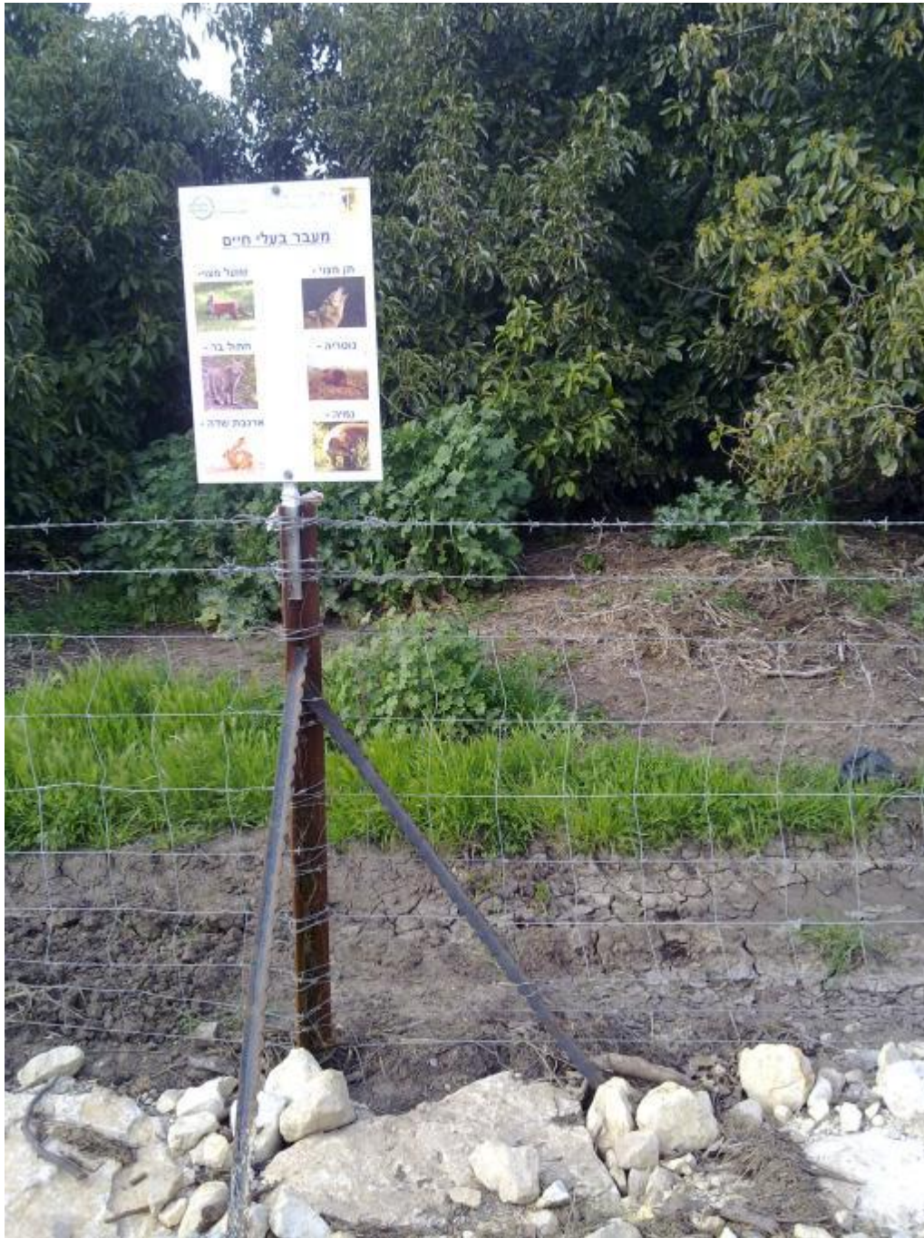
גדר אוסטרלית בתוספת שני חוטי תיל למניעת טיפוס בנוסף קיימת "שמלה" למניעת חפירות של דורבנים וחזירי בר (דותן, 2014).
