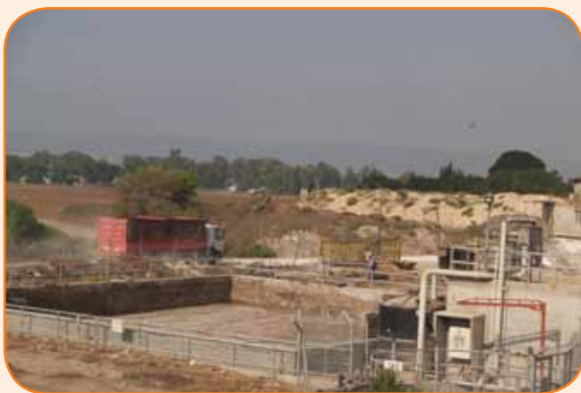
מרכיבי פתרון הקצה - מפרדה ומשטח אצירה ומיצוק
