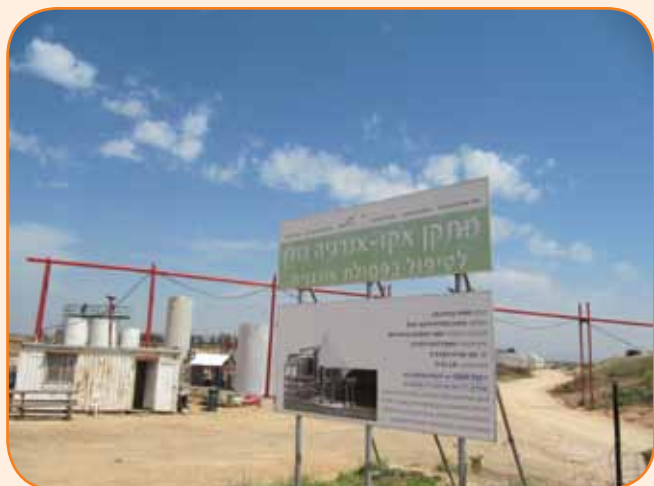
מתקן הביוגז בגולן בתהליך הבנייה
